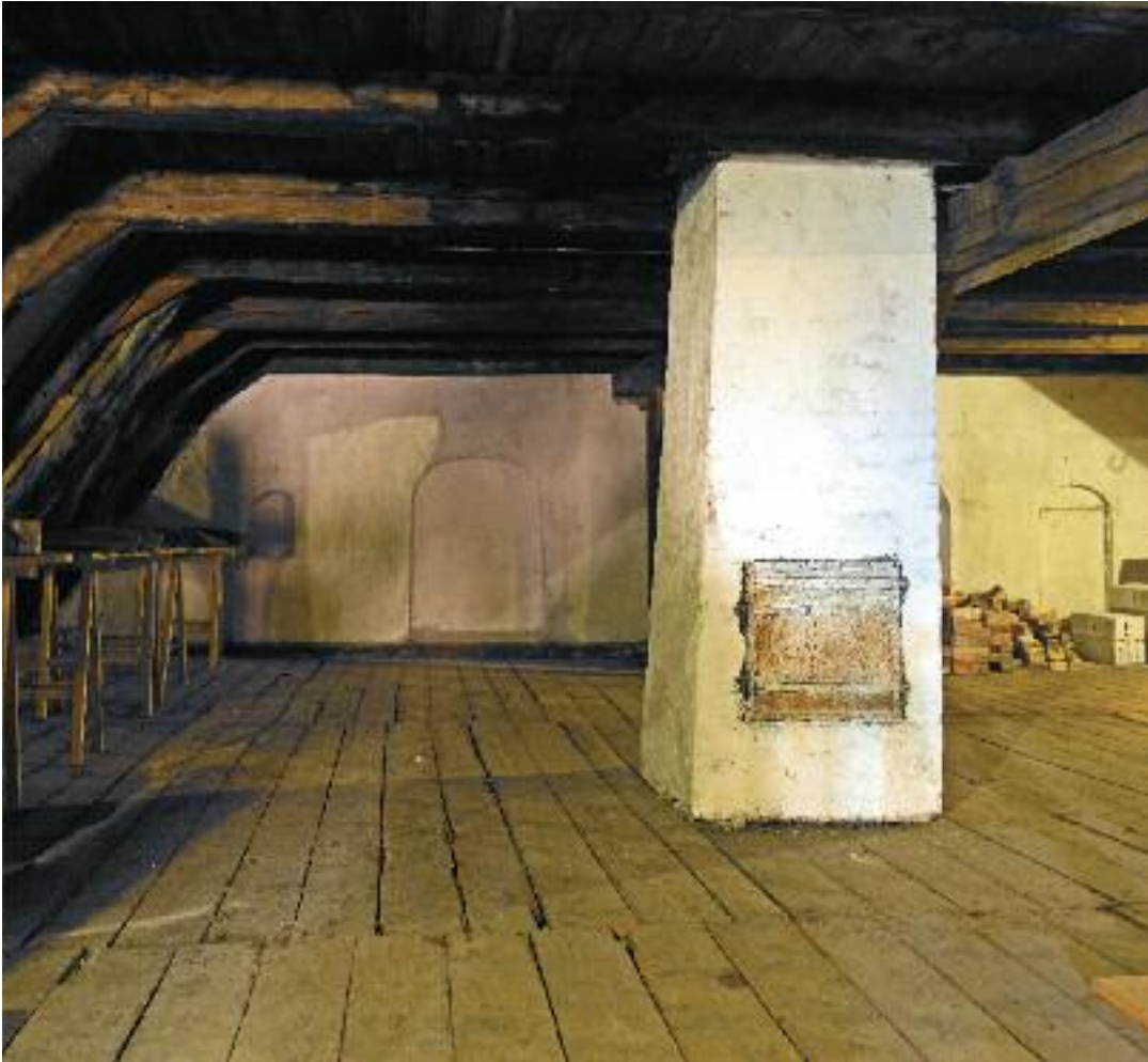
Loftet over forhuset med oven og tilmurede vinduesnicher i sydgavlen.
