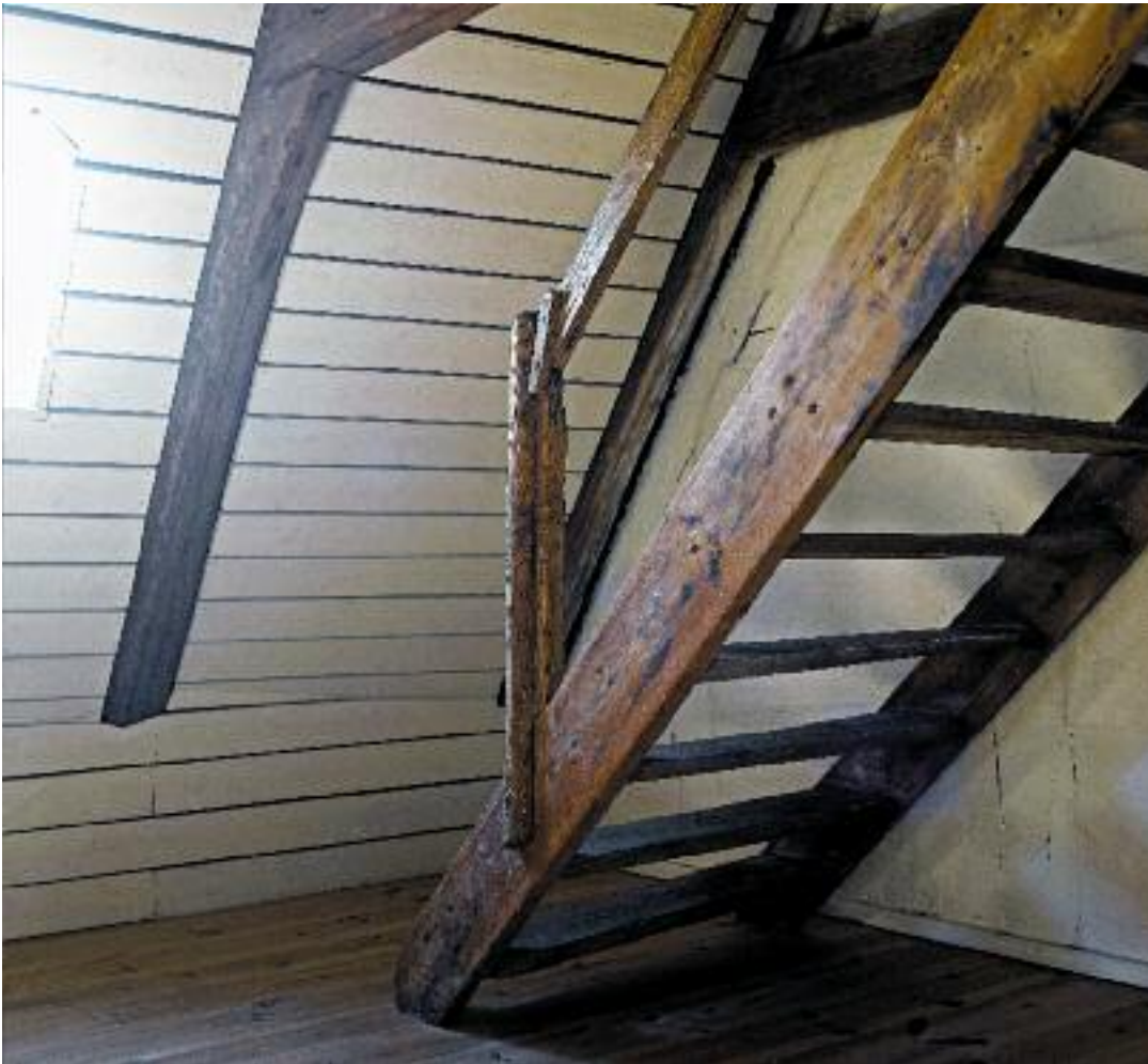
Detalje fra hanebåndsløftet. Trappen til hemsen der ud- gør resterne af det ellers ned- revne øverste dæk på loftet.
