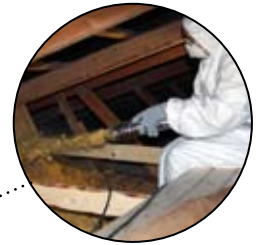
Loftet højisoleres
