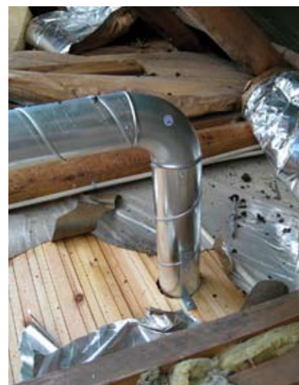
Det mekaniske ventilationsanlæg på Langøvænget 8 under monteringen. Her er brugt batts fordi isoleringen sker samtidig med etablering af ventilationsanlægget. Nu sørger det automatisk for frisk luft til familien.
