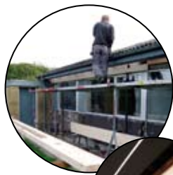
Rem og søjler bygges ind i den nye vestfacade
