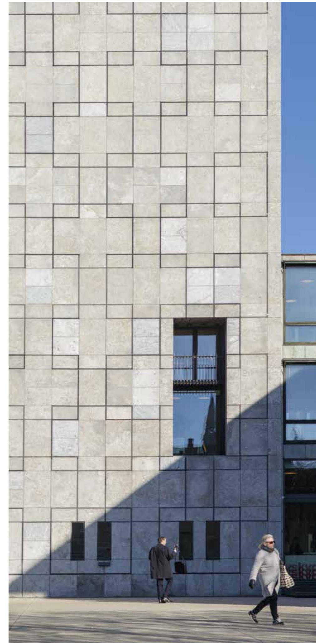
Højhusets gavle er bygningens primære ansigt udadtil. De er beklædt med lysegrå marmorplader, lagt i et simpelt og ensartet, men meget virkningsfuldt geometrisk mønster, der fanger øjet fra lang afstand.
