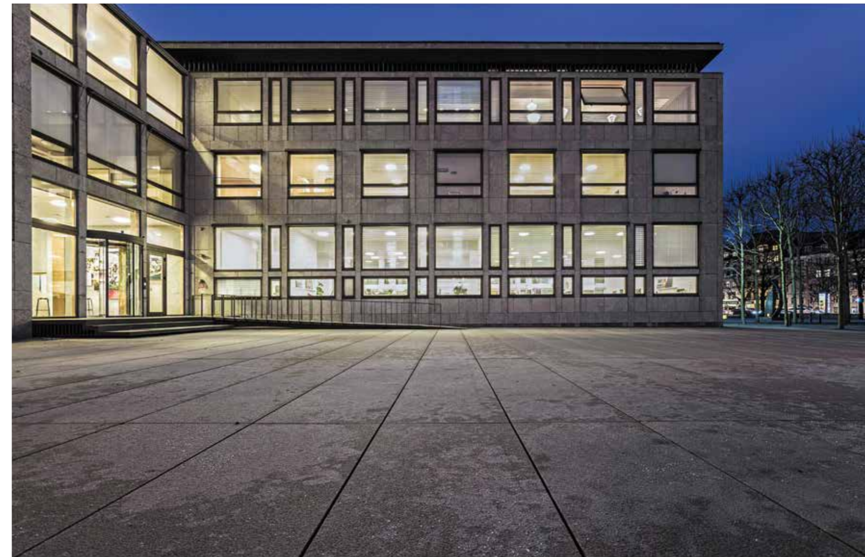
Jarmers Plads 2 består samlet af tre bygninger. Fløjen yderst mod boulevarden rejser sig som et højhus i ni etager, mens fløjen ud mod Ørstedsparken er i tre etager. Imellem sig har de en treetages indgangs- og forbindelsesbygning, der fortsætter bagud i en lavere fløj.
