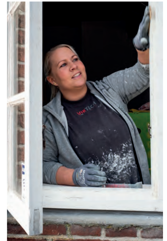
Window restoration, Marskgården in Højer.
