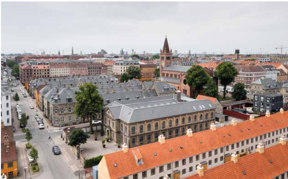
For at få plads til Søetatens Pigeskole måtte to af de gule længer i Nyboder lade livet. Skolen mimer længernes karakter ved at gentage de to parallelle længer med den fælles gård i midten.
